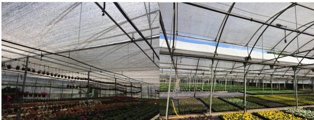
Figura 5 – Malhas de sombreamento e janelas superiores para melhorar a ventilação e retirada de ar quente e úmido das estufas.
